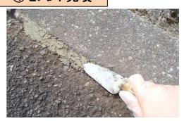
コテなどを用いて目地に目地バリ充填セメントを 充填し、目地からはみ出さないようにしながら 表面を平らに均します。
