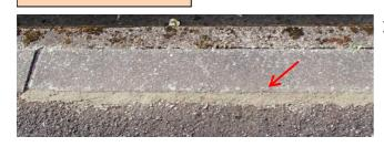
施工後は養生し、翌日以降に 目地バリ充填セメントが固まったのを確認してから 目地バリシートの敷設を行ってください。
