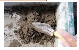
目地バリ充填セメントに水を加え、よく練り混ぜてください。目地バリ充填セメント1袋に対して水600mlが目安です。
