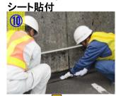
シートを中央の溝に 沿って折り曲げ、L型 部分へフィットするよ うに貼り付け、シート が浮かないように手 で圧着を行う。
