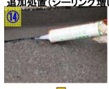
下地路面の凹凸が大 きい場合は、アタッチ でシーリング処理する。
