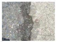
施工面の窪み プライマーを大量に塗布すると、この部分にプライ マーが溜まり、養生不良になりやすい。窪みのある 場合は事前にセメントを充填するなどの処理が必要。
