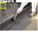
ゴム製ハンマーで シートを均一に叩いて 圧着させる。 端部から接着剤、ア タッチが多くはみ出し た場合はヘラなどで かきとる。
